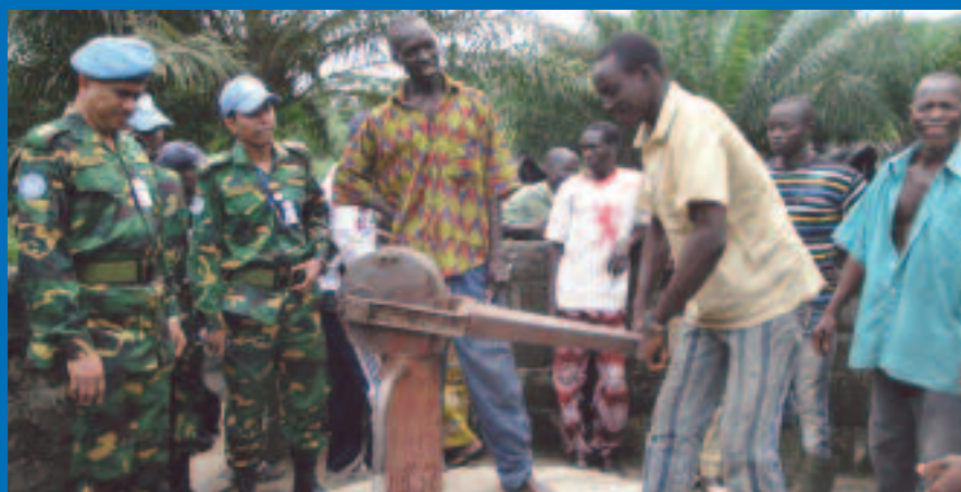
...et installe des pompes hydrauliques villageoises © UN / ONUCI
